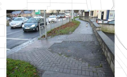
CONTROLLED CROSSING POINT. RED BLISTER TACTILE PAVING NEEDS TO BE REPAIRED AND EXTENDED TO THE WALL.
